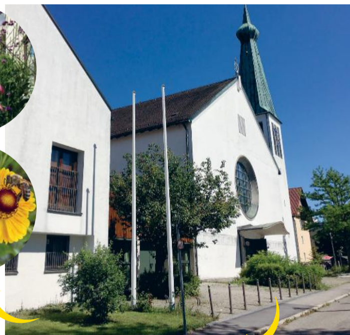
Einseitige Strauchbepflanzung im Vorbereich St. Konrad (Bestand)
