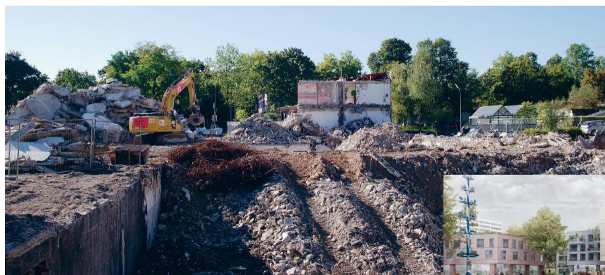
Links: Baugrube auf dem Gelände Wiesentfeller Straße 68
